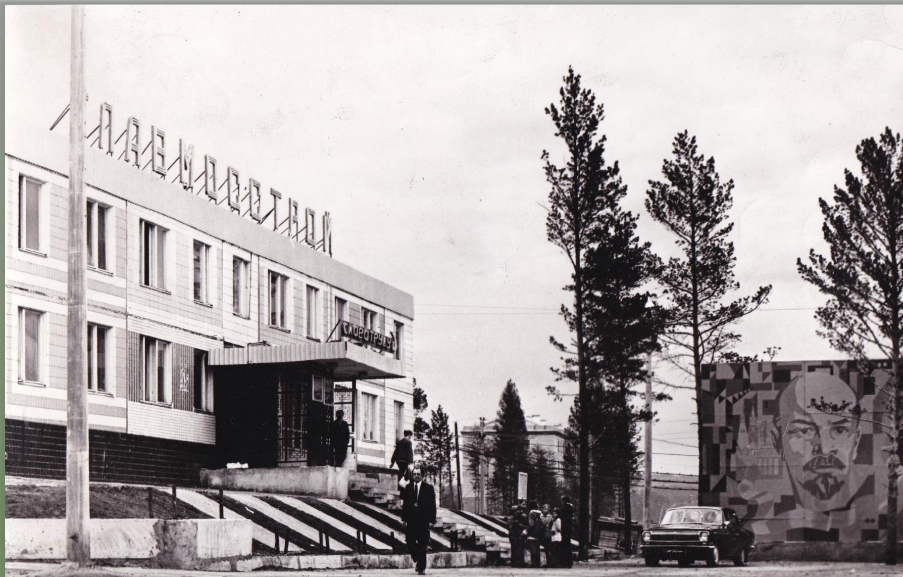
Административное здание (контора) УС Главмосстроя в Тынде. 1980-е гг.
