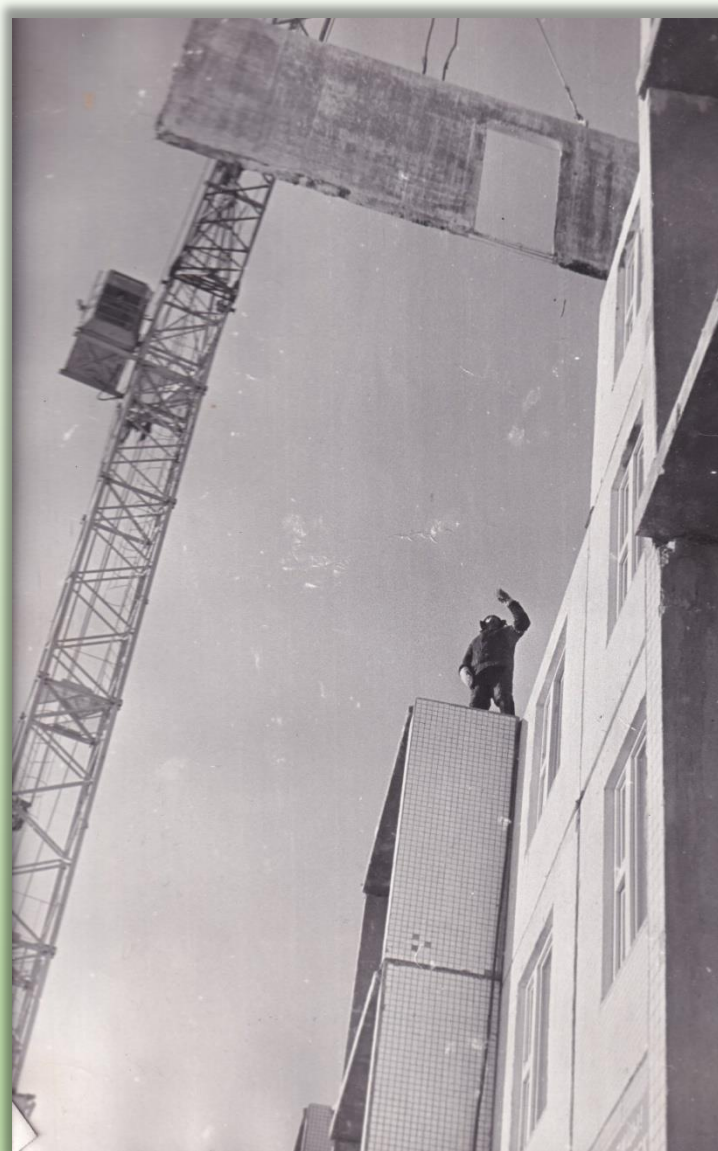
Монтажники-высотники. 1970-е гг.
