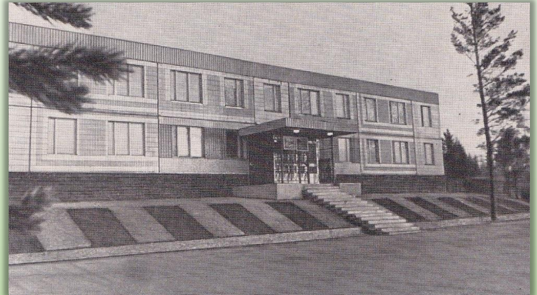
Административное здание Управления строительства Главмосстроя в районе станции Тынды. 1977 г.
