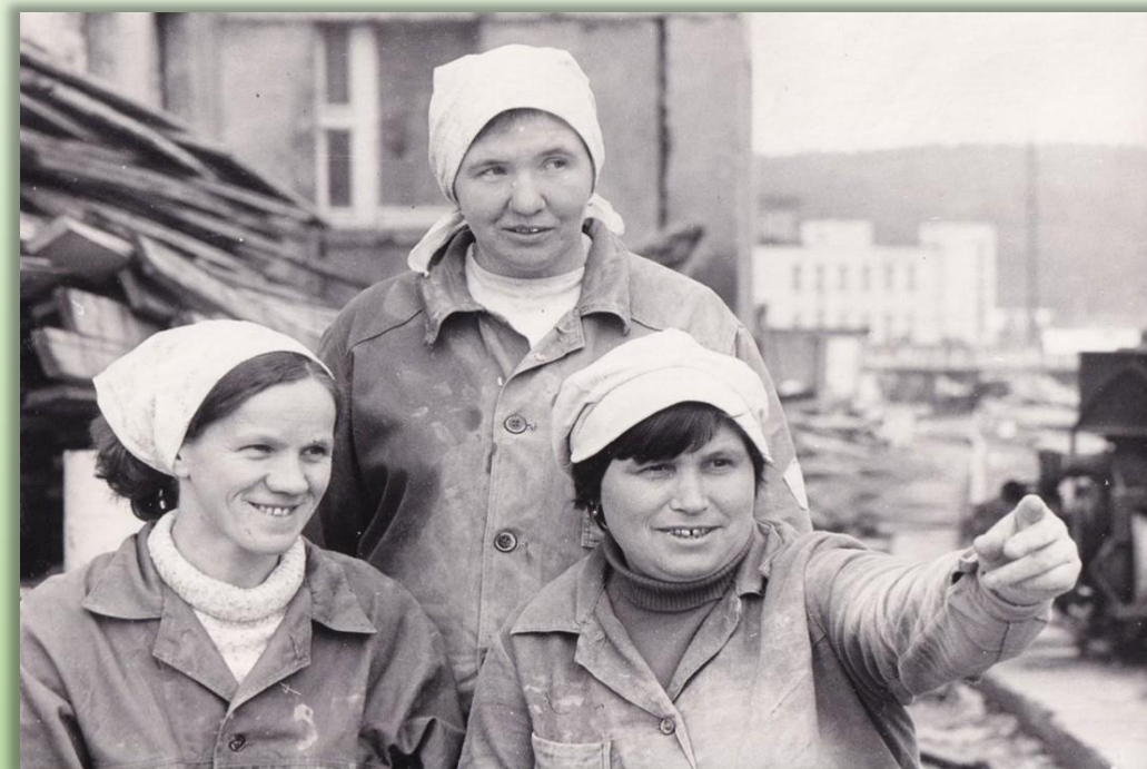
Штукатуры из бригады П. И. Кузина. 1980-е гг.
