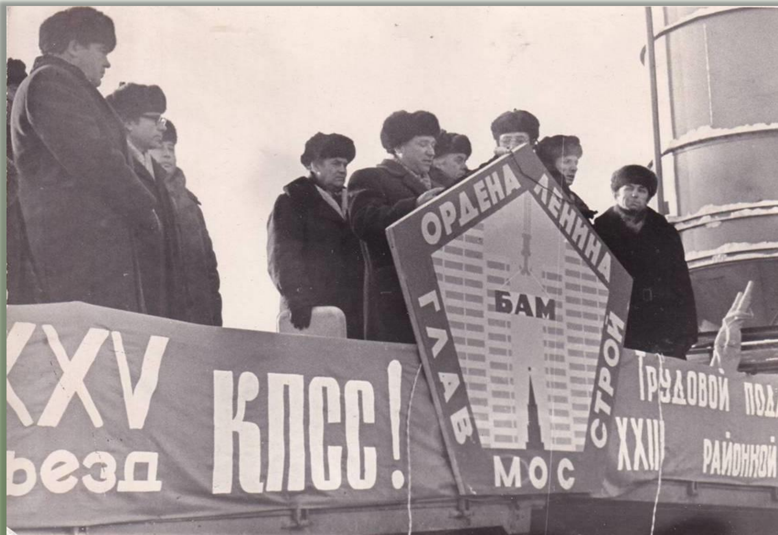
Сдача в эксплуатацию растворобетонного завода УС Главмосстроя в Тынде. Посёлок Сокольники. 1976 г.
