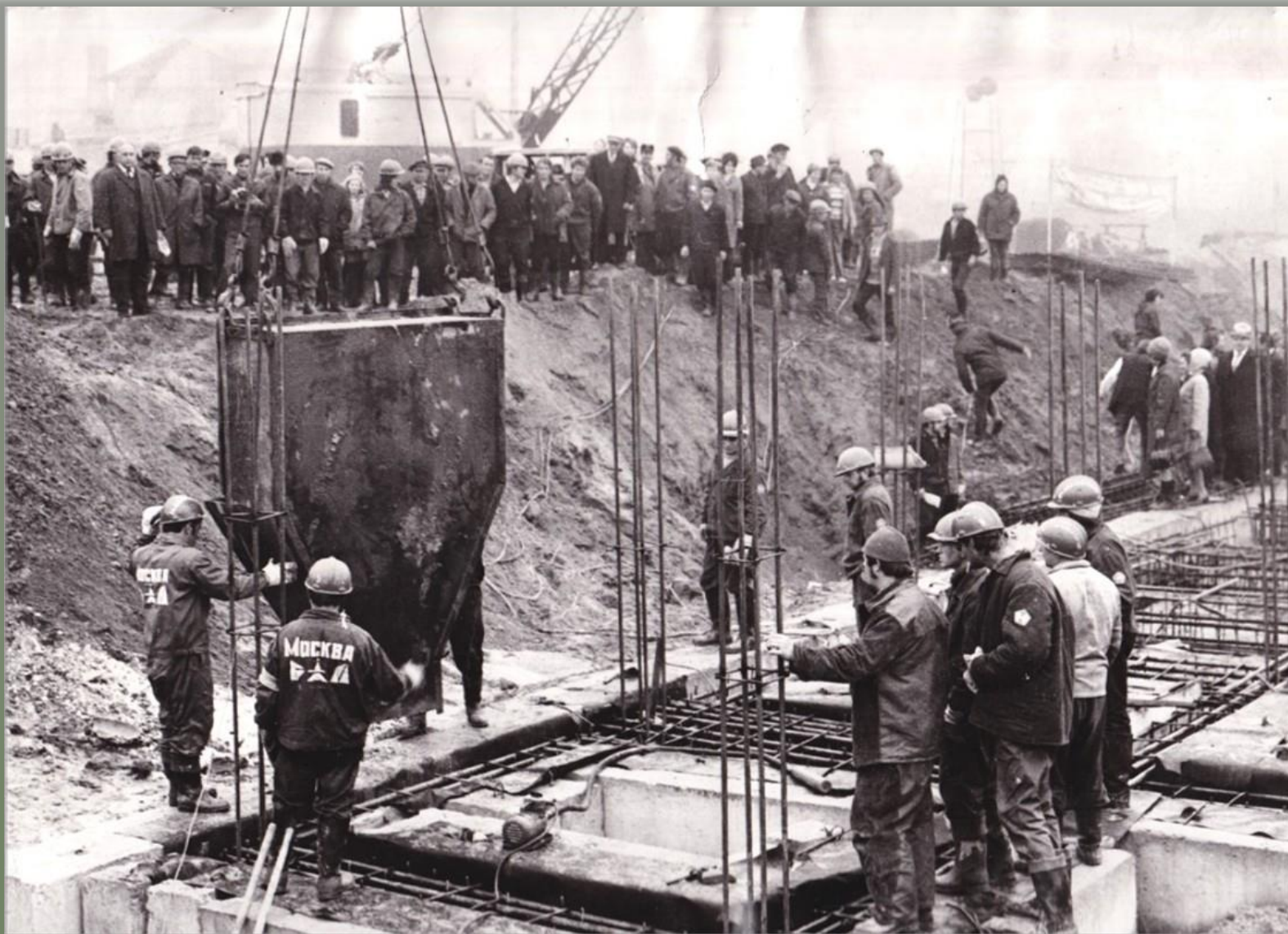
Работает бригада А. Д. Гусева. Идёт закладка фундамента первого девятиэтажного дома. Сентябрь 1975 г.
