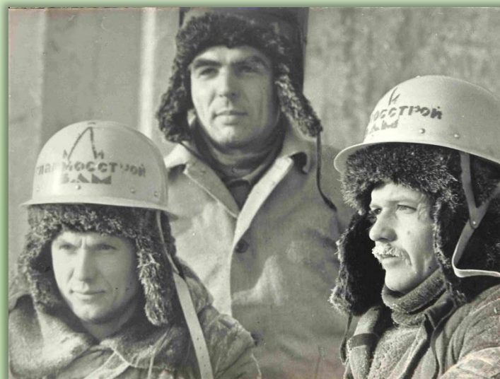
Монтажники. 1970-е гг.
