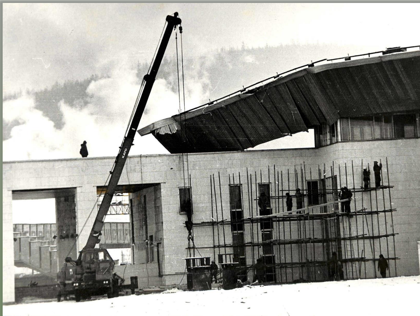
Строительство железнодорожного вокзала. Тында. 1984 г.
